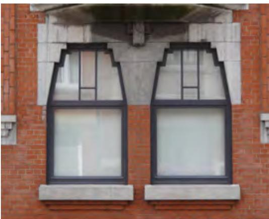
Exemples de châssis neufs avec un encadrement aux découpes géométriques dessiné en fonction de la forme de l'encadrement en pierre. Les divisions à angle droit cadrent parfaitement avec le style Art déco.
