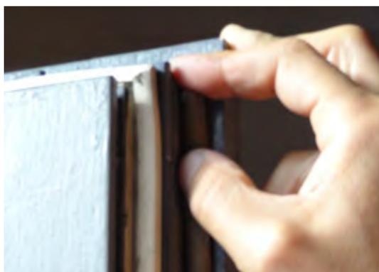
☹ Ces exemples montrent des finitions de mauvaise qualité : le mastic de fixation des verres coule (haut), et les joints n'assurent pas une étanchéité continue (bas).
