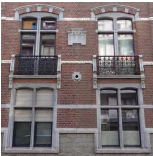
Deux façades jumelles avec des nouveaux châssis : les profils de ceux de droite débordent très peu de l'encadrement en pierre, ce qui assure un éclairage supérieur aux châssis à sections larges de la maison de gauche.
