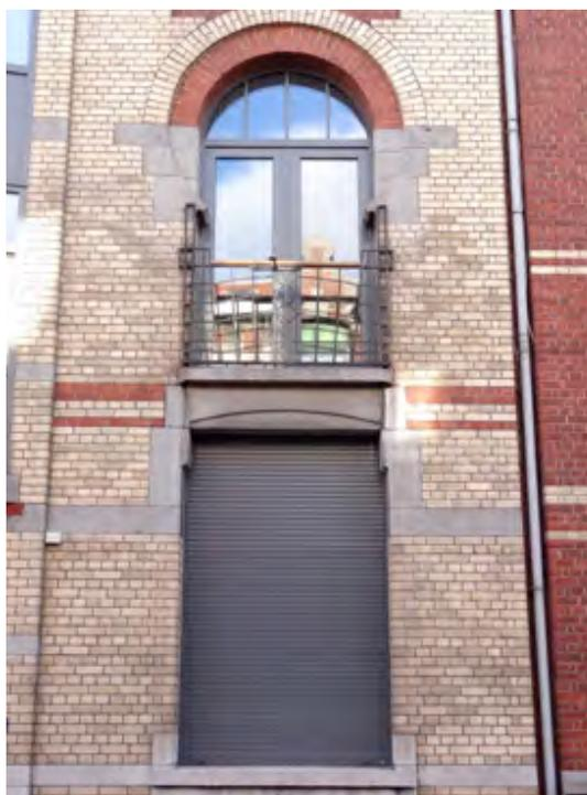
La couleur gris-vert du volet présente le double avantage d'être peu salissante et d'être identique à celle des châssis, pour une harmonie en position close. Le caisson d'enroulement est masqué à l'intérieur.
