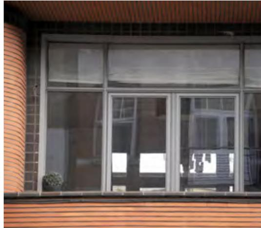
La structure métallique, avec des profilés très fins et des divisions droites, est parfaitement adaptée au style 'paquebot' de la façade.
