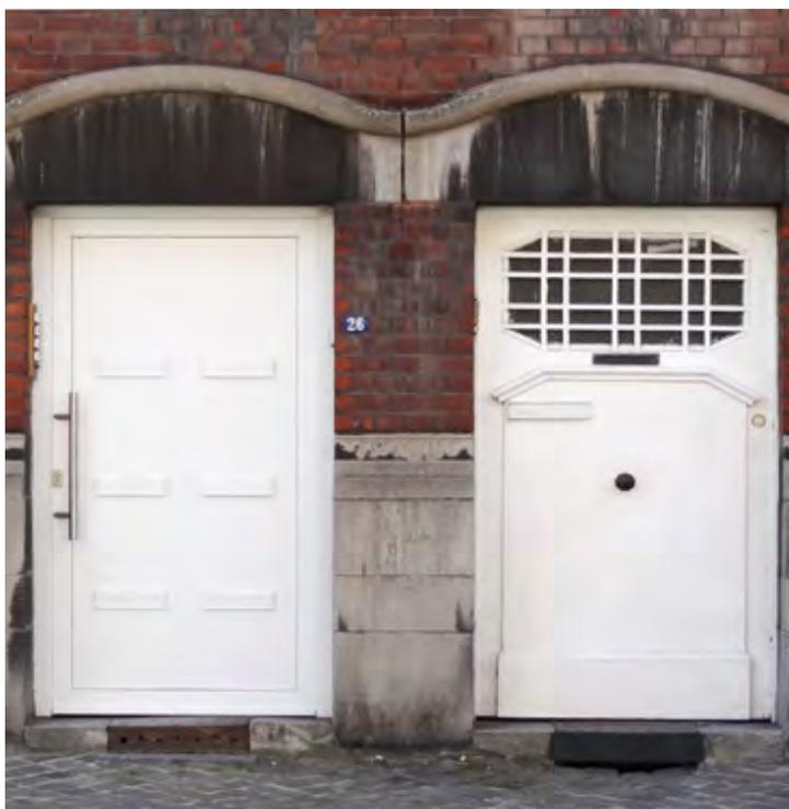
☹️ Véritable ‘carte de visite’ d’un immeuble, la porte d’entrée constitue un élément à part entière de l’architecture. On le comprend en comparant la solution d’origine (droite) et le regrettable remplacement par une structure banale (gauche).
