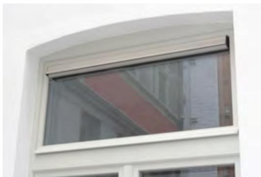
La grille de ventilation est intégrée de manière discrète dans le haut du châssis : l'aération évite les problèmes de condensation.
