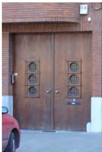
Quelques exemples de châssis anciens aux formes originales : courbes, cintrées, ovales, rondes, incurvées, rayonnantes, en triangle... Il est toujours recommandé d'envisager d'abord les solutions de conservation des châssis d'origine s'ils présentent des détails remarquables. L'isolation de la baie peut être améliorée par d'autres techniques que par un remplacement.
