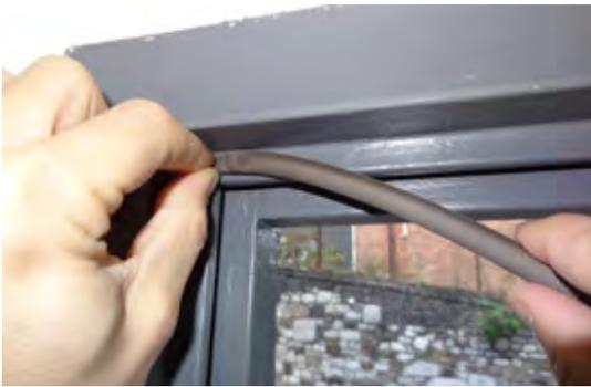
Peu coûteux, les joints souples à coller sur les châssis existants augmentent considérablement leur étanchéité à l'air. Ils obstruent les espaces de plusieurs millimètres d'épaisseur.
