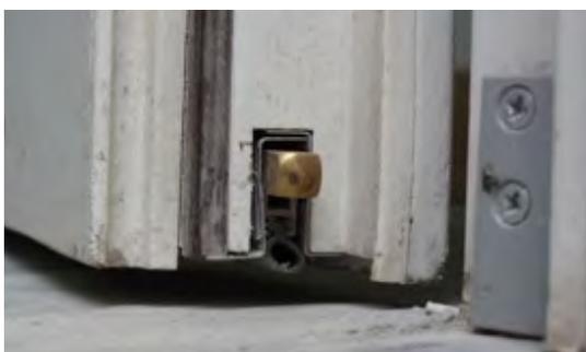
Les joints automatiques sont une solution pour améliorer l'isolation de la partie inférieure des portes : pressé en position fermée, le bouton fait pression sur le joint qui s'abaisse.
