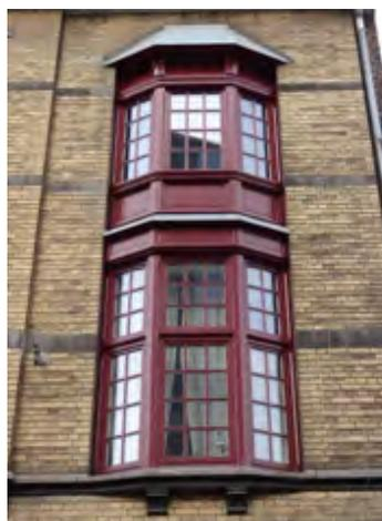
Nouvelle structure reproduisant à l'identique les formes et couleurs de l'oriel d'origine, sur du double vitrage.
