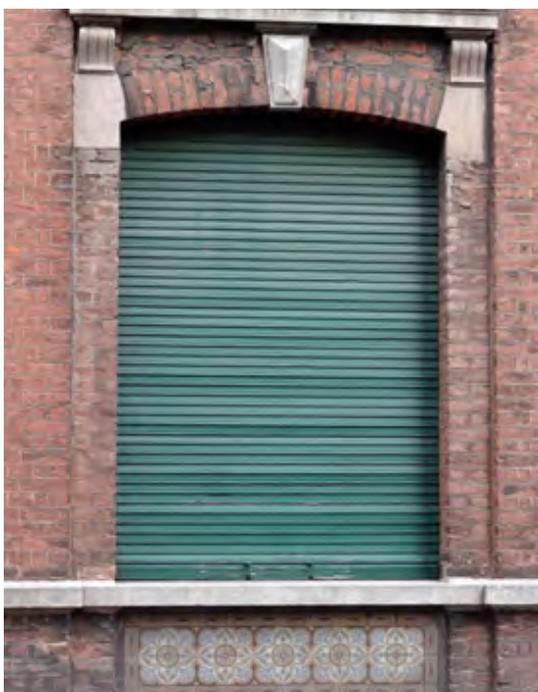
Régulièrement repeints, les volets traditionnels en bois peuvent être conservés longtemps. A condition d'isoler le caisson et les trous de passage des sangles, ils conservent une utilité en matière d'isolation thermique. Ils protègent par ailleurs des tentatives d'intrusion.
