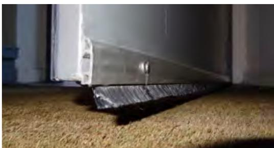
L'ajout d'une brosette isolante contre la partie inférieure du battant constitue une autre solution pour améliorer l'étanchéité en contact avec le seuil.
