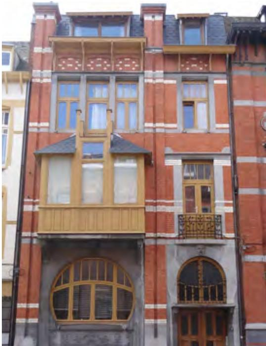
Les fenêtres des étages et l'oriel ont été remplacés à l'identique. Leur couleur reproduit celle d'origine, créant une cohérence avec la porte et la fenêtre d'imposte conservés au rez-de-chaussée.
