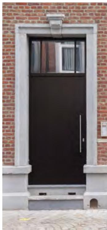
Trois types de solutions pour ces portes neuves, adaptées au style de la façade : à l’identique (porte en bois reproduisant la porte d’origine), porte de style ‘traditionnel’ (porte en bois avec moulures et verre résistant adaptée à une façade de style éclectique) ; porte au design contemporain sobre (aluminium peint en noir deux incisions latérales).
