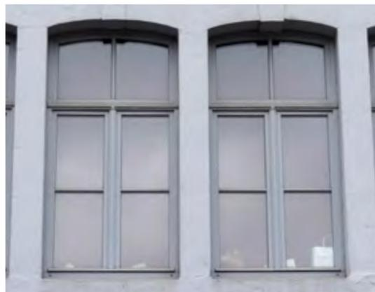
Les châssis en bois sont parfaitement adaptés aux baies d'une façade du 18e siècle, avec une partie supérieure courbe et des croisillons à l'extérieur du vitrage. Les moulures courbes donnent du relief.
