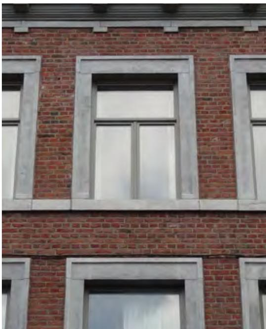
La qualité de la mise en place est primordiale à la fois sur le plan esthétique et sur le plan de l'efficacité thermique : aucun orifice ne doit laisser passer l'air entre le châssis et le reste de la façade.
