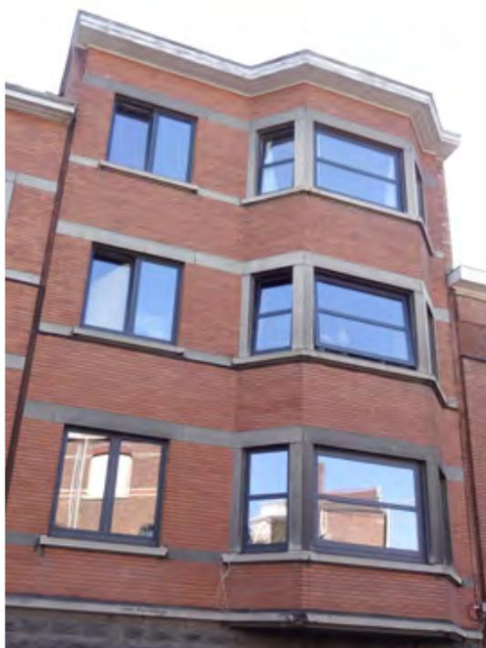
Châssis métallique à double vitrage. La division horizontale des grands châssis de la travée de droite est parfaitement adaptée aux lignes de composition de la façade de style Art déco.
