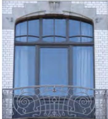
Châssis neuf en bois, avec double vitrage, reproduisant à l'identique une partie des formes d'origine, tout en intégrant une porte oscillo-battante.
