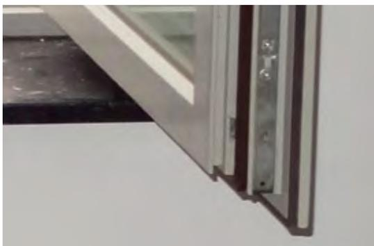
Les nouveaux châssis possèdent au moins 'deux frappes', c'est-à-dire deux plans de contact entre parties ouvrantes et fixes.
