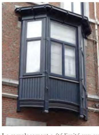
Le remplacement a été limité aux ouvrants et à leur encadrement : formes, matériaux et couleurs sont adaptés au reste de la structure.
