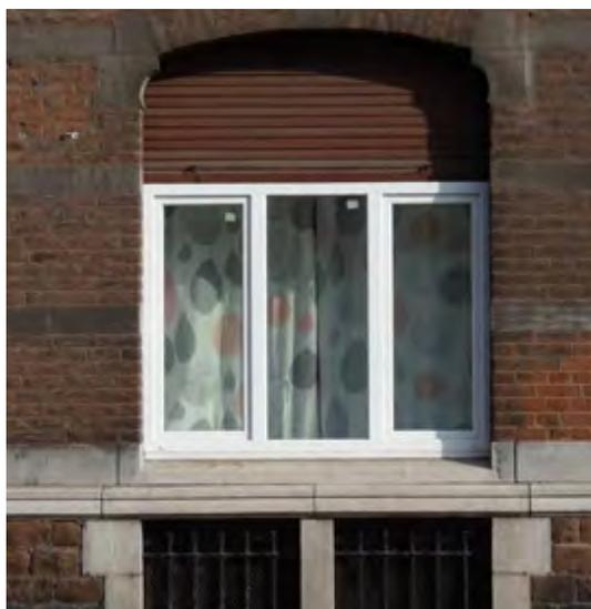
☹ L'étanchéité et l'isolation thermique ne sont efficaces que si une barrière d'étanchéité est réalisée avec soin entre le châssis et le mur. Ce n'est peut-être pas le cas pour cette baie dont la partie supérieure est seulement obstruée par l'ancien volet en bois.
