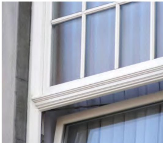
Les divisions à petits bois ou croisillons sont placées à l'extérieur du vitrage pour rester visibles et créer une profondeur. Le relief est aussi animé par les moulures des parties fixes.
