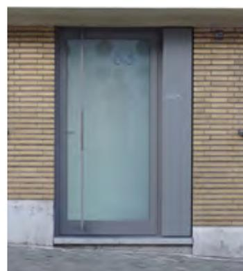
Porte de style contemporain en harmonie avec les lignes géométrique de la façade et le parement de briques plates. N° gravé dans le vitrage.
