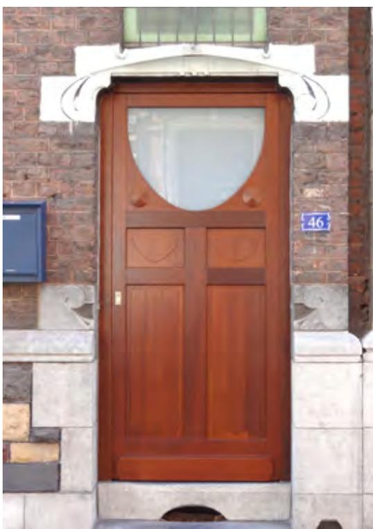
Nouvelle porte mêlant le verre et le bois. Les formes sont inspirées de la porte d'origine, pour s'adapter parfaitement à une façade en briques et pierres du début du 20<sup>e</sup> siècle.
