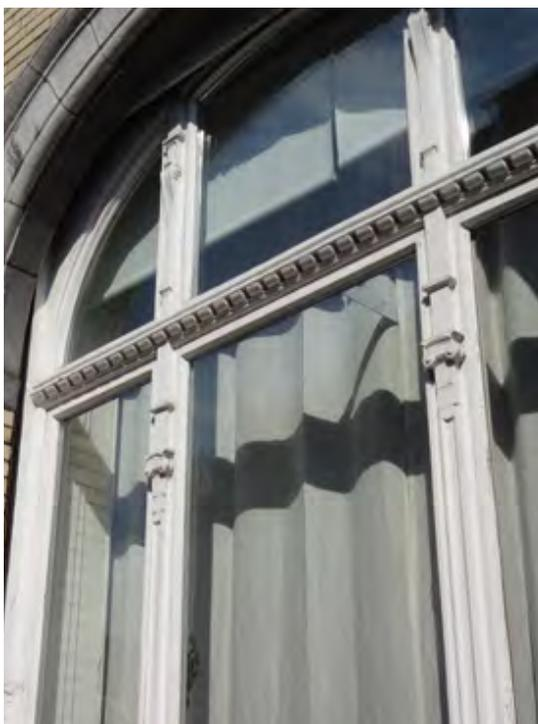
Voici un exemple de châssis richement décoré, avec des denticules et des motifs de chapiteaux ioniques sur les montants verticaux.
