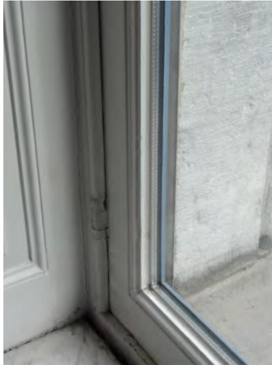
Un double vitrage peut être installé dans la structure d'origine. Certaines firmes sont spécialisées dans ce type de travaux qui permettent de conserver l'aspect historique.
