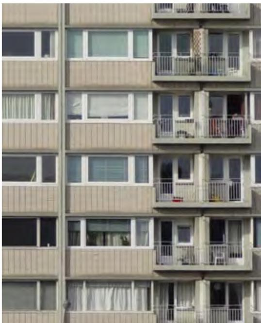
Le remplacement implique généralement des sections plus larges que dans les châssis métalliques d'origine. Il est recommandé de choisir les solutions les plus fines possibles et de bien aligner les divisions d'un étage à l'autre.
