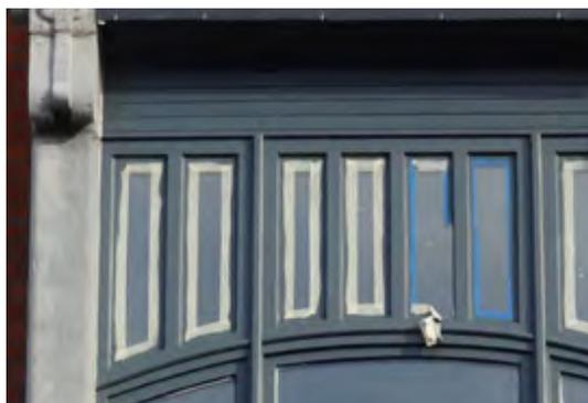
Du papier collant de protection a été placé sur les vitrages pour éviter les taches lors de la mise en peinture.
