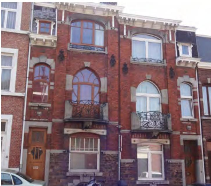
Ces deux façades jumelles de style Art nouveau étaient à l'origine absolument identiques. 😊 Les portes et la grande baie du rez-de-chaussée de la façade de gauche sont les seuls châssis qui sont encore d'origine. Les nouveaux châssis aux étages reproduisent dans le bois les formes courbes originelles.
