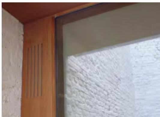
Exemple de système de ventilation 'invisible', intégré dans le montant du châssis en bois.
