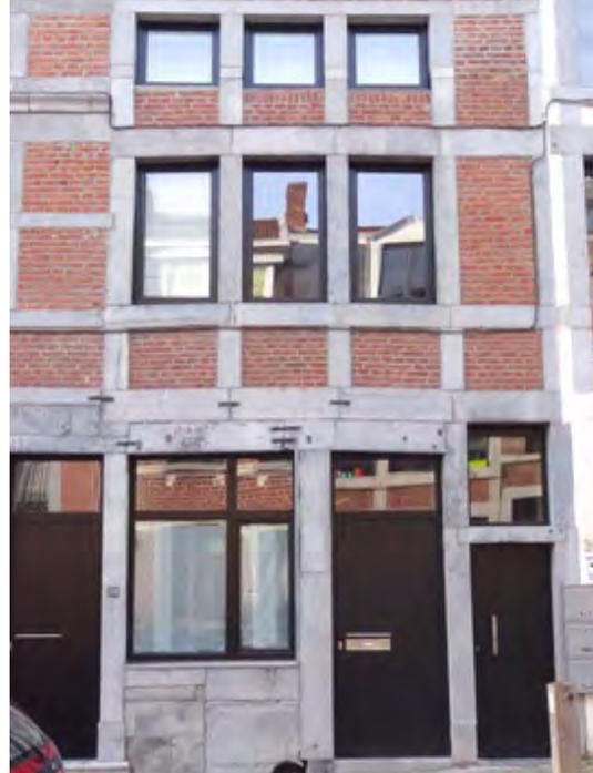
Les châssis de l'étage épousent la forme des encadrements en pierre (17<sup>e</sup> s.). Le meneau de la fenêtre du rez a été placé dans le prolongement des divisions verticales pour respecter les lignes de force de la façade.
