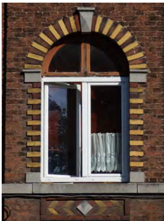
☹ Dans ce cas, seule la partie inférieure du châssis d'origine a été remplacée. Cette solution n'améliore pas l'étanchéité : l'investissement a été réalisé en pure perte.
