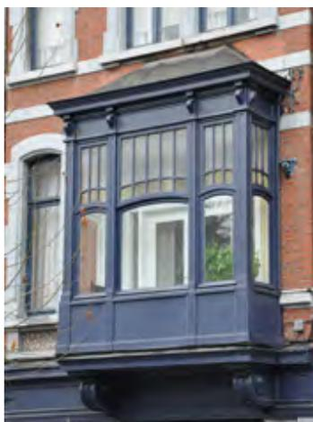
L'installation d'un second châssis intérieur a permis d'améliorer les performances en conservant l'aspect d'origine.
