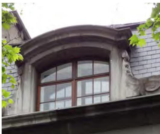
La pose d'un second châssis vers l'intérieur a permis d'améliorer les performances thermiques de la baie tout en conservant les structures d'origine.
