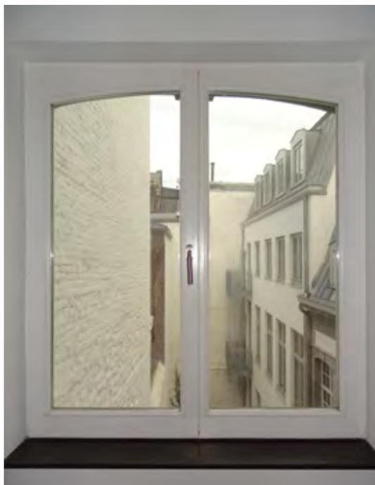
Il est nécessaire de vérifier la qualité des finitions intérieures : présence d'une barrière isolante, qualité du plafonnage, planéité des surfaces, fixation de la tablette...
