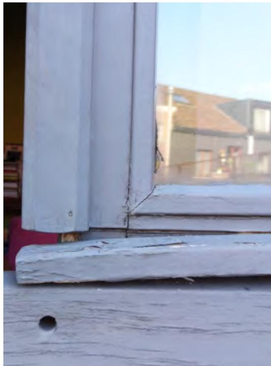
☹ La partie inférieure des ouvrants, appelée le jet d'eau ou rejet, est la partie la plus fragile, car elle reçoit toute l'eau qui ruisselle sur le châssis. Trop abîmée, elle doit être remplacée.
