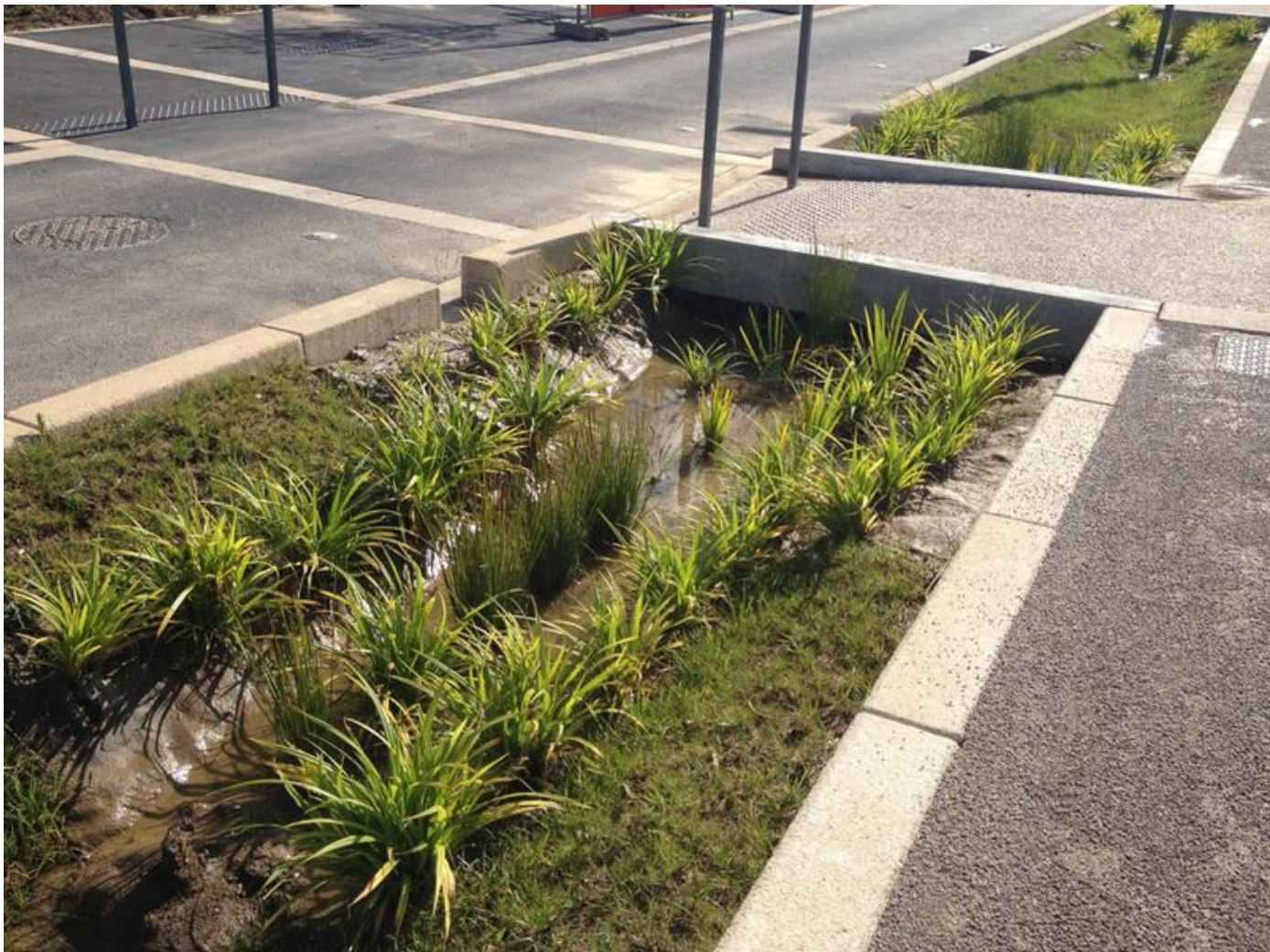
Noue végétalisée avec eau de pluie en cours d'infiltration dans l'écoquartier du Raquet près de Douai en France. Source et ©: http://www.leraquet.fr/quest-ce-quun-ecoquartier/la-gestion-de-leau-de-pluie/
