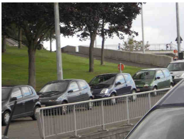
Chemin au dessus du mur de soutènement de la rue Frankignoul
