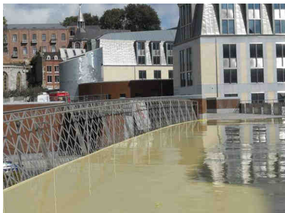
Nouvelle passerelle gare Palais
