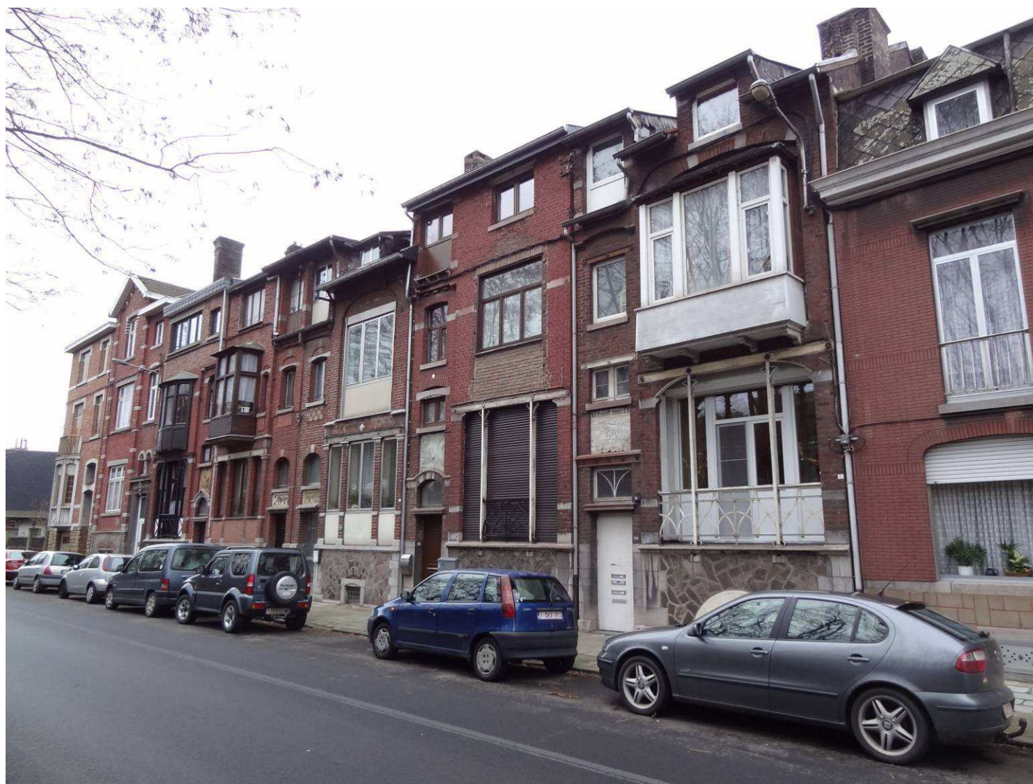
La séquence de façades de la rue Renory
