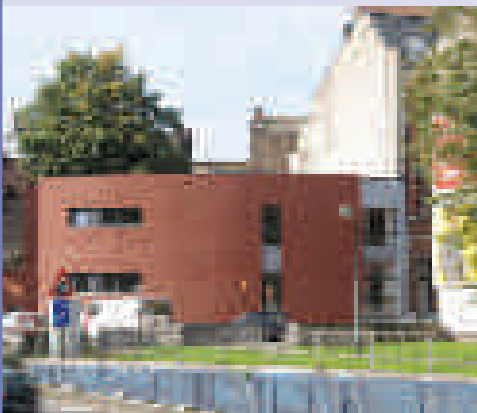
Architecte : Contraste Architecture Maître d'ouvrage : asbl « En Famille »
