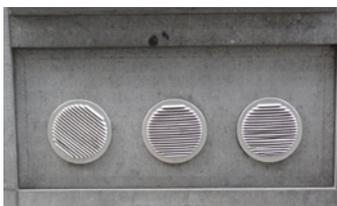
Exemples d'évacuation en toiture et de grilles de ventilation discrètes.
