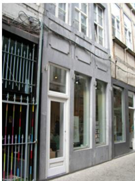
Composition d'un nouveau rez-de-chaussée commercial en fonction de la partie supérieure de la façade : restitution des axes porteurs de charge des étages, utilisation de la pierre calcaire.
