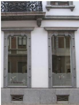
Agrandissement d'anciennes fenêtres vers le bas : maintien des trumeaux (axes porteurs de charge) et nouvelles pierres d'encadrement de même style que les pierres existantes.
