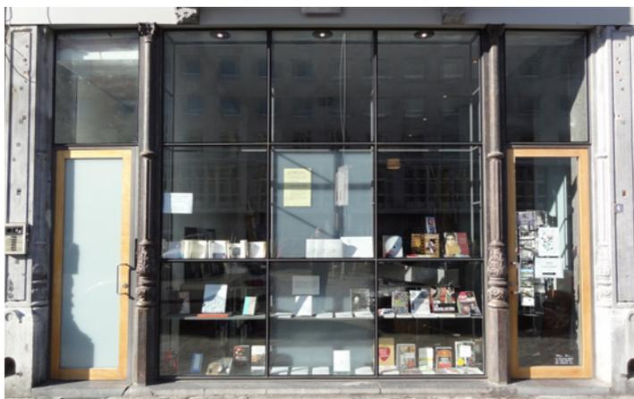
Éléments contemporains (vitrine centrale sur un châssis métallique, portes) intégrés à des parties anciennes conservées (piliers de fonte et encadrements en pierre)
