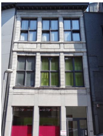
Structure de la devanture composée par des pierres calcaires traditionnelles
