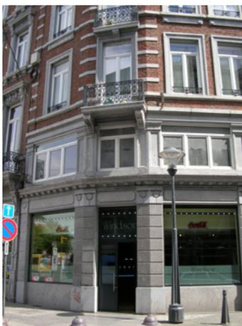
Recomposition d'une devanture commerciale au rez-de-chaussée en prolongeant les axes porteurs de charges des étages. La même pierre calcaire est employée que celle présente au niveau des étages.
