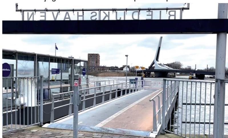
Figure 11 : Rampe d'accès à Merwekade, Dordrecht.
