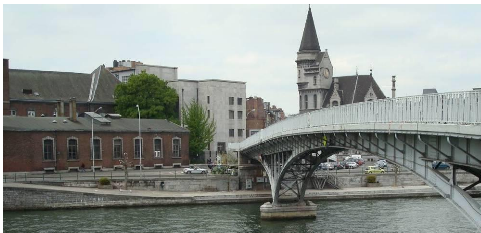
Figure 77 : Vue de la zone d'implantation de l'arrêt XX Août
