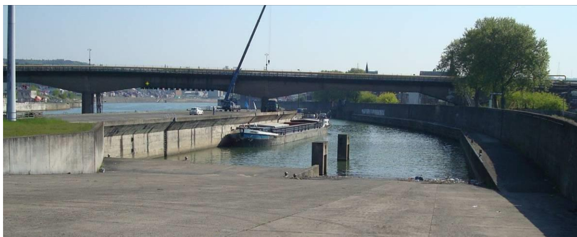
Figure 84 : Rampe RORO et bassin de Seraing, à moins de 5 min de navigation du Pont de Seraing
