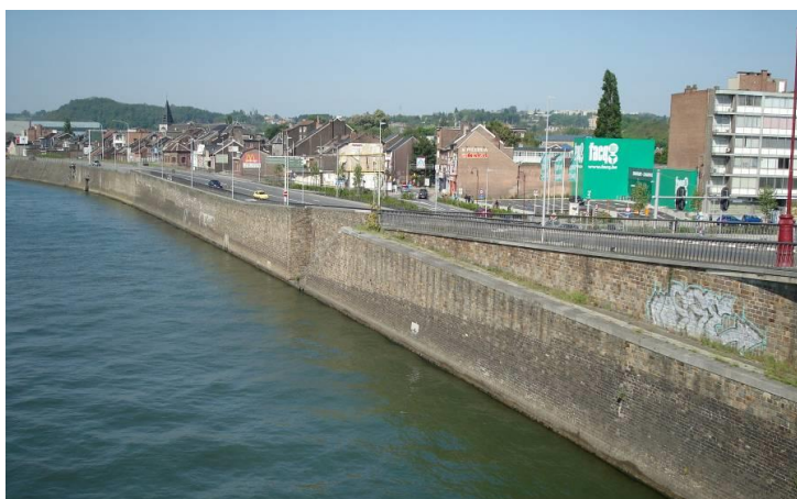
Figure 60 : quai haut - Pont de Seraing
