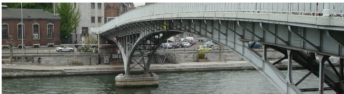
Figure 58 : quai bas - Passerelle Saucy
