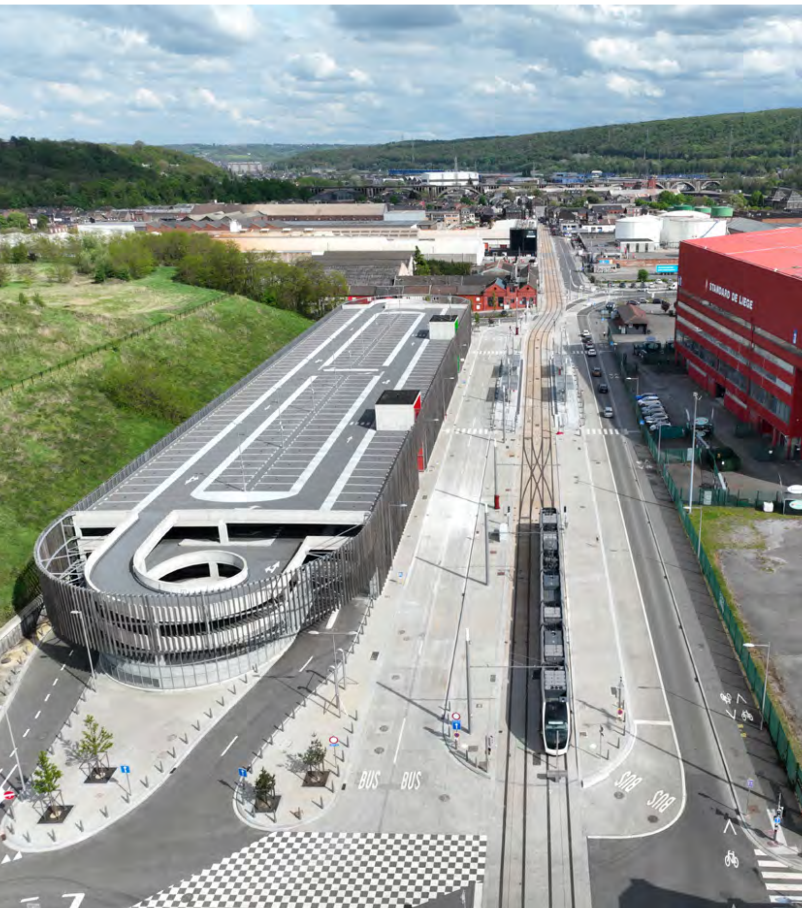
Station Standard, vue vers Place Ferrer : au pied du terril se localisent le P+R de 700 places, la station et le terminus pour la ligne - avr. 2025
