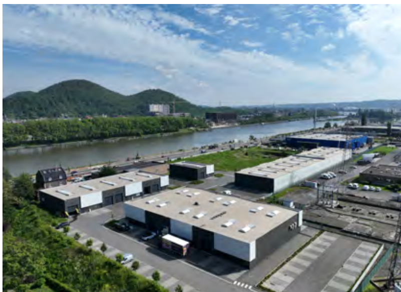
Droixhe Business Parc (phase 1) – mai 2024
