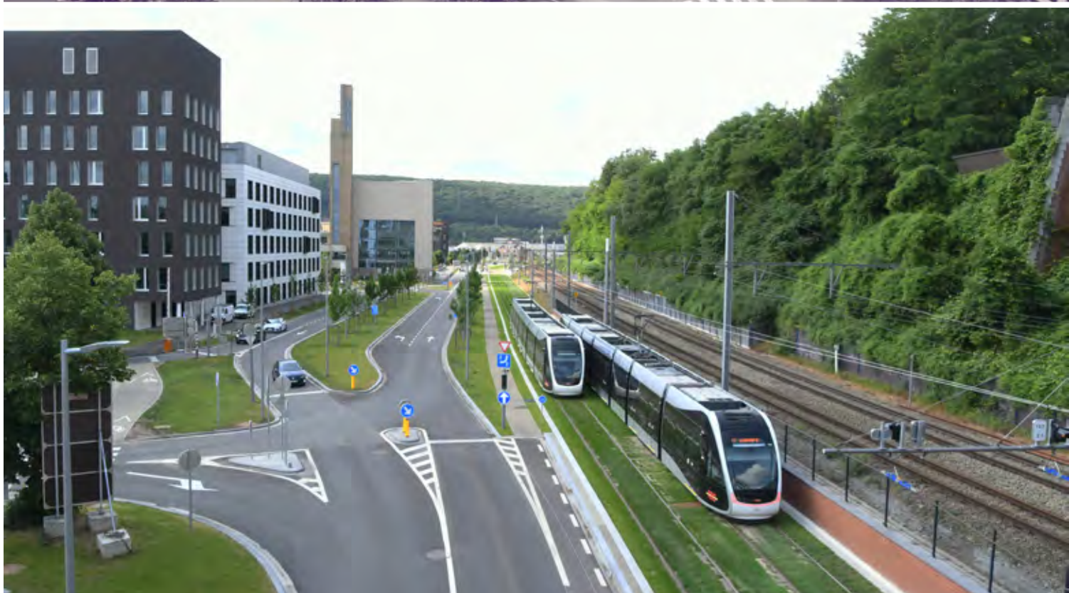
APRÈS - rue Ernest Solvay - juin 2025
