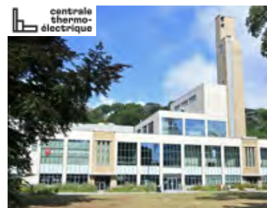
Centrale Thermo-électrique Cité des Métiers Inauguration : 2024
