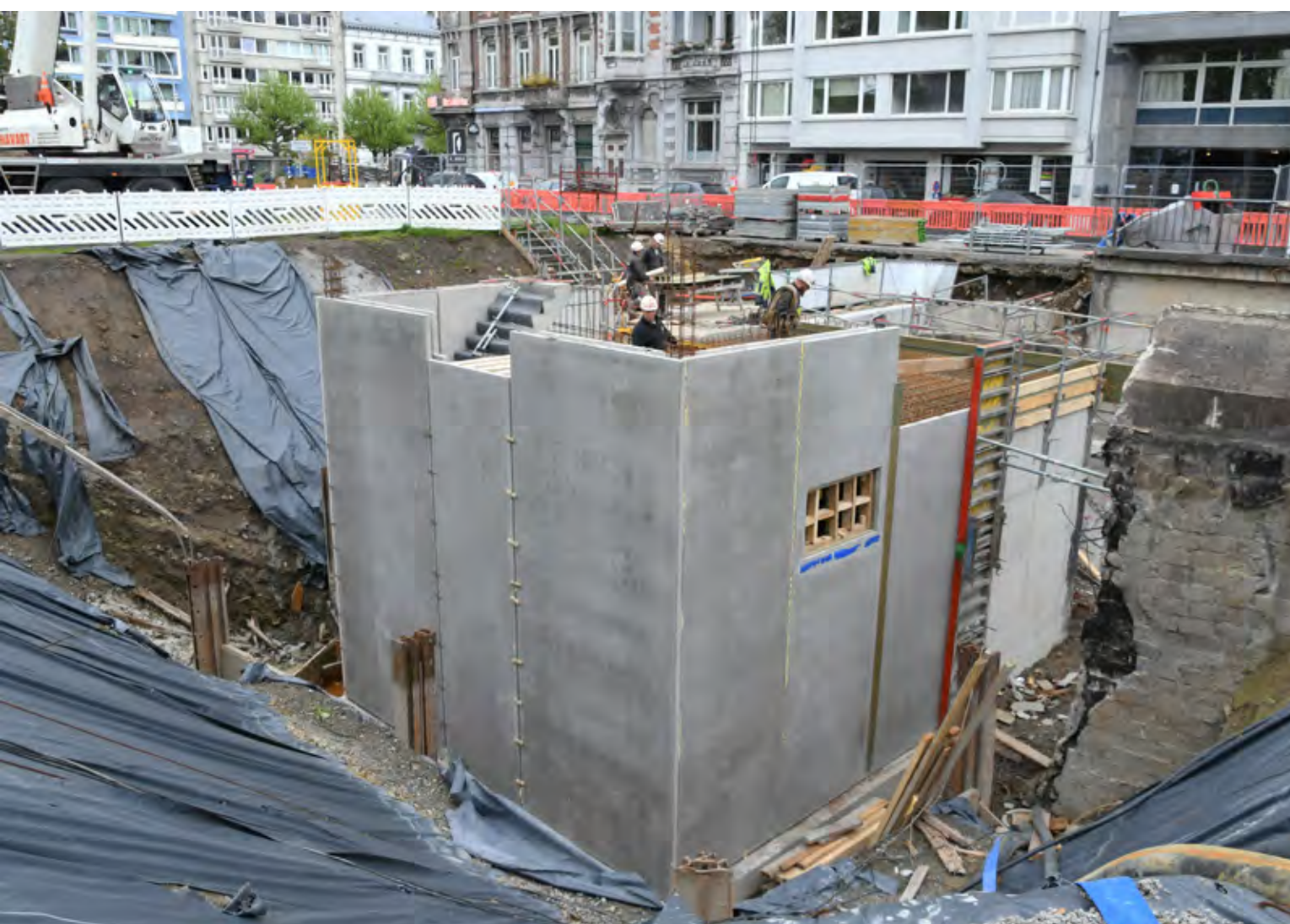
Avenue Rogier, construction d'une cabine technique enterrée - mai 2021
