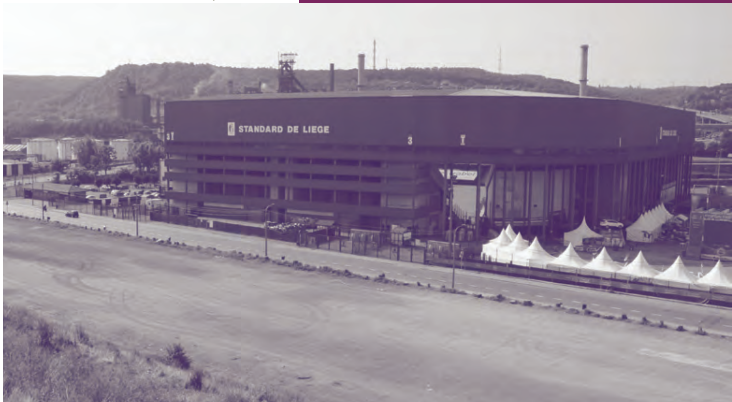
AVANT – rue Ernest Solvay – oct. 2014
