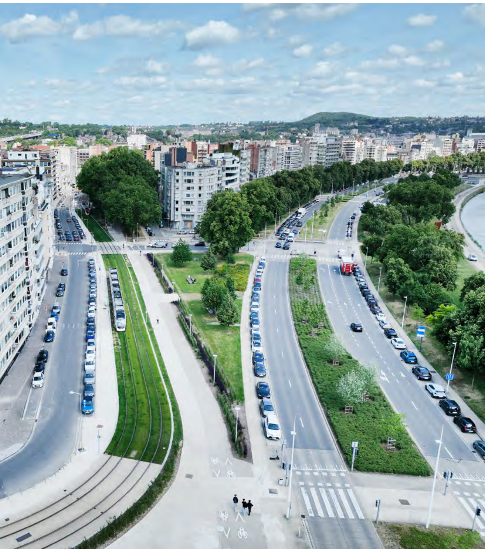
APRÈS - avenue Blonden, vue vers Station Blonden - juin 2025 Les quais de Meuse ont fait l'objet d'une première phase de réaménagement en 2012.
