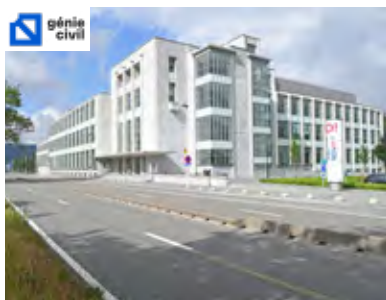
Institut de Génie civil Espaces de travail partagés Inauguration : 2016
