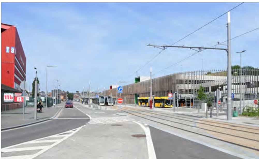
APRÈS - rue Ernest Solvay - juin 2025
