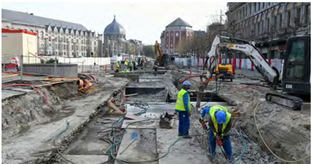
EN TRAVAUX - place Saint-Lambert - mars 2022
